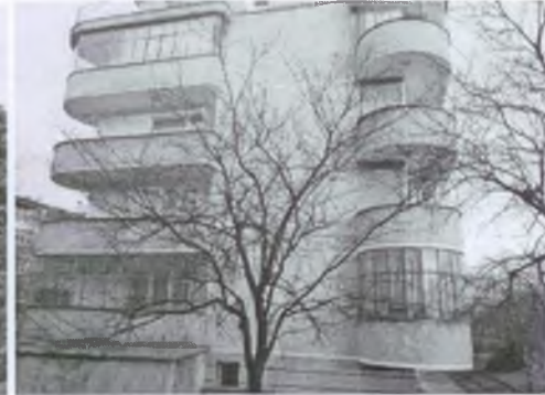
Фиг. 4. Фасада запад и югозапад
